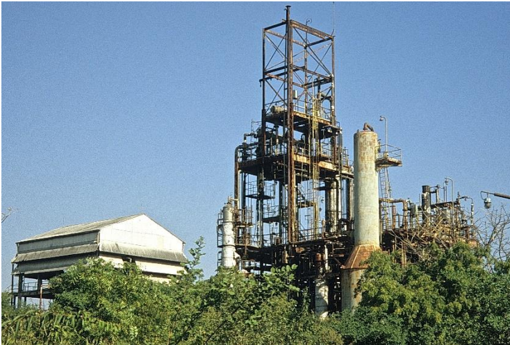
26 Die ehemalige Fabrik von Union Carbide
