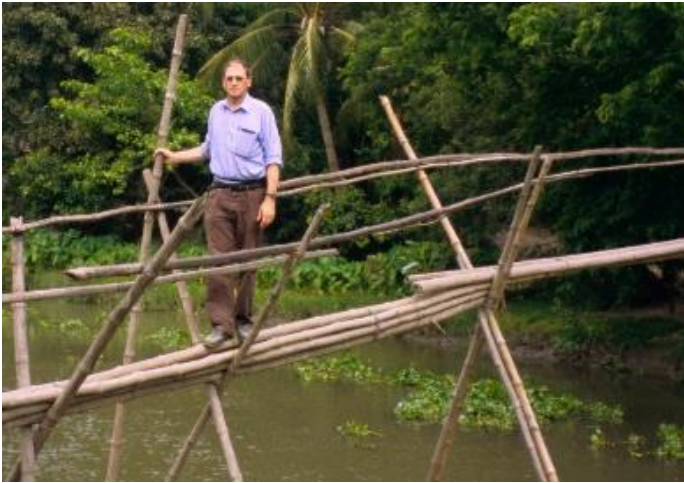
67 Einfache Bambusbrücke auf dem Lande
