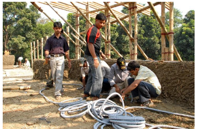
46 Verlegen der Elektro-Rohre
