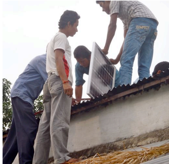
Montage der Panels durch unsere Lehrlinge
