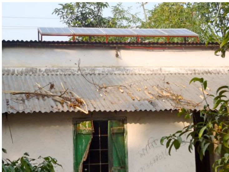
Von den zentralen Panels wird der Strom an die Häuser verteilt.
