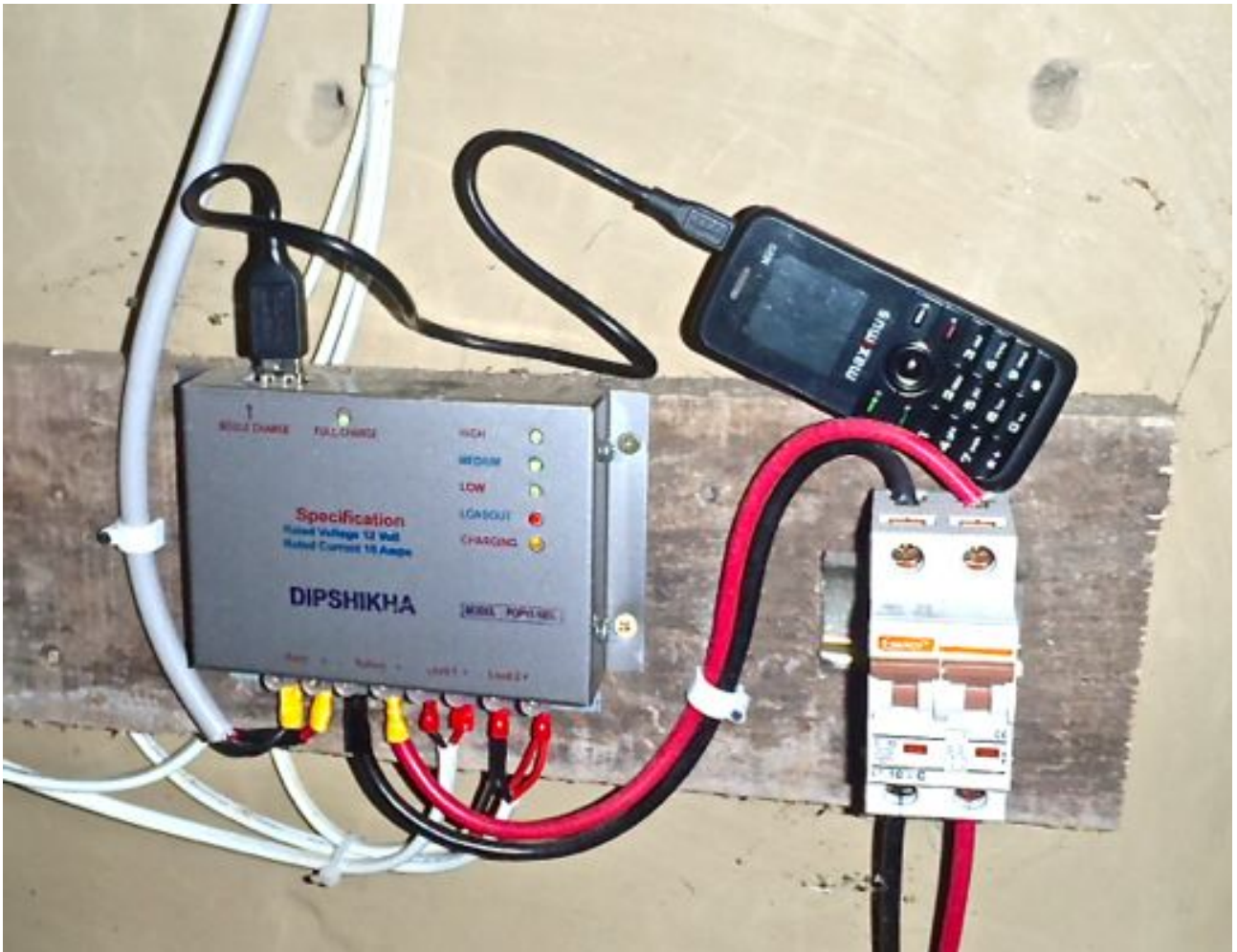
Ganz schlau, mit Sonnenenergie die Batterien der Natels oder der Taschenlampen zu laden.
