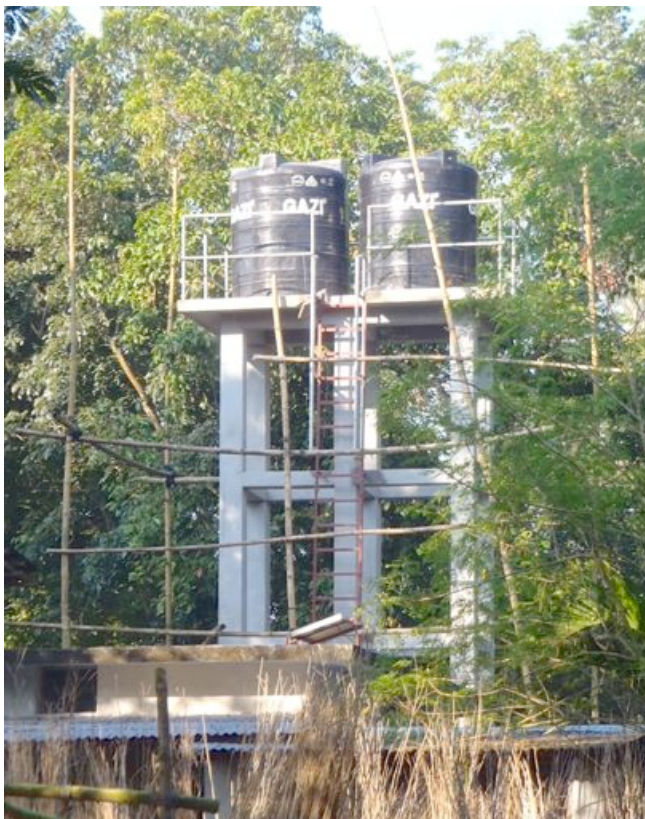
Die neue Wasserversorgung.
