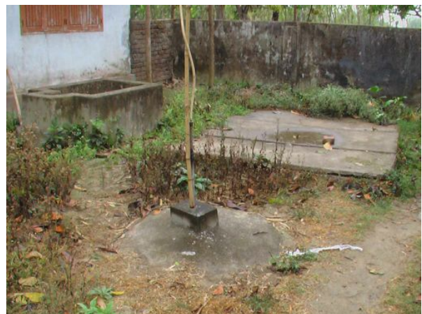
Uralter Bio-Reaktor, der brennbares Gas zum Kochen und nebenbei wertvollen Dünger erzeugt.
