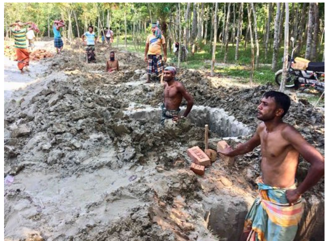
Aushub für die Umgebungsmauer.
