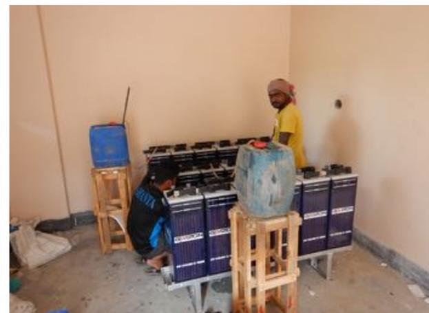
**Bild 14: Befüllen der Batterien**
