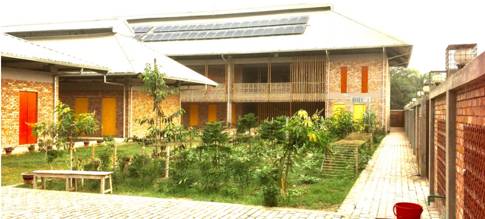
Hauptgebäude, Ansicht von Süden mit Fotovoltaik-Anlage
