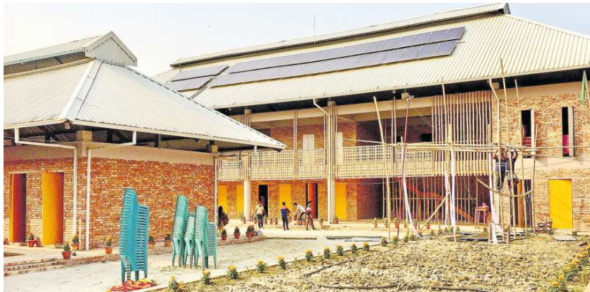
Das Hauptgebäude der zweiten Elektrikerschule mit der Fotovoltaikanlage zur Stromerzeugung.
