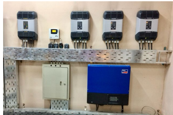
Fotovoltaikanlage auf dem Hauptgebäude mit Inverter für Inselbetrieb und Rückspeisung
