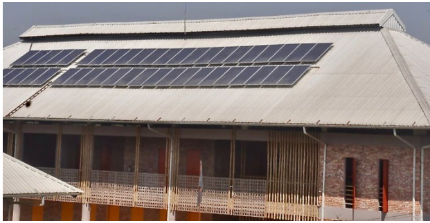
Fotovoltaikanlage auf dem Hauptgebäude mit Inverter für Inselbetrieb und Rückspeisung
