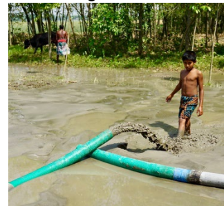
Aufschüttung mit Sand
