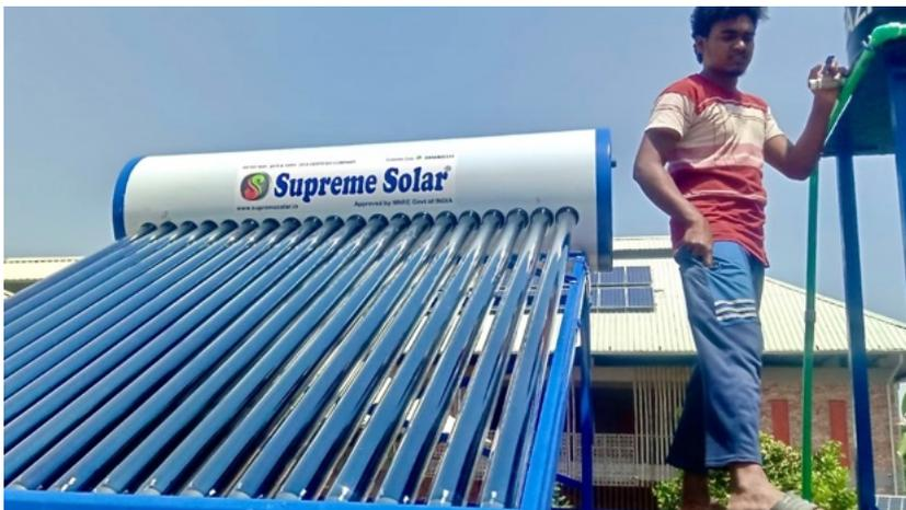
DER KOLLEKTOR BRAUCHT KEINE FREMDENERGIE – ER FUNKTIONIERT MIT SCHWERKRAFT
